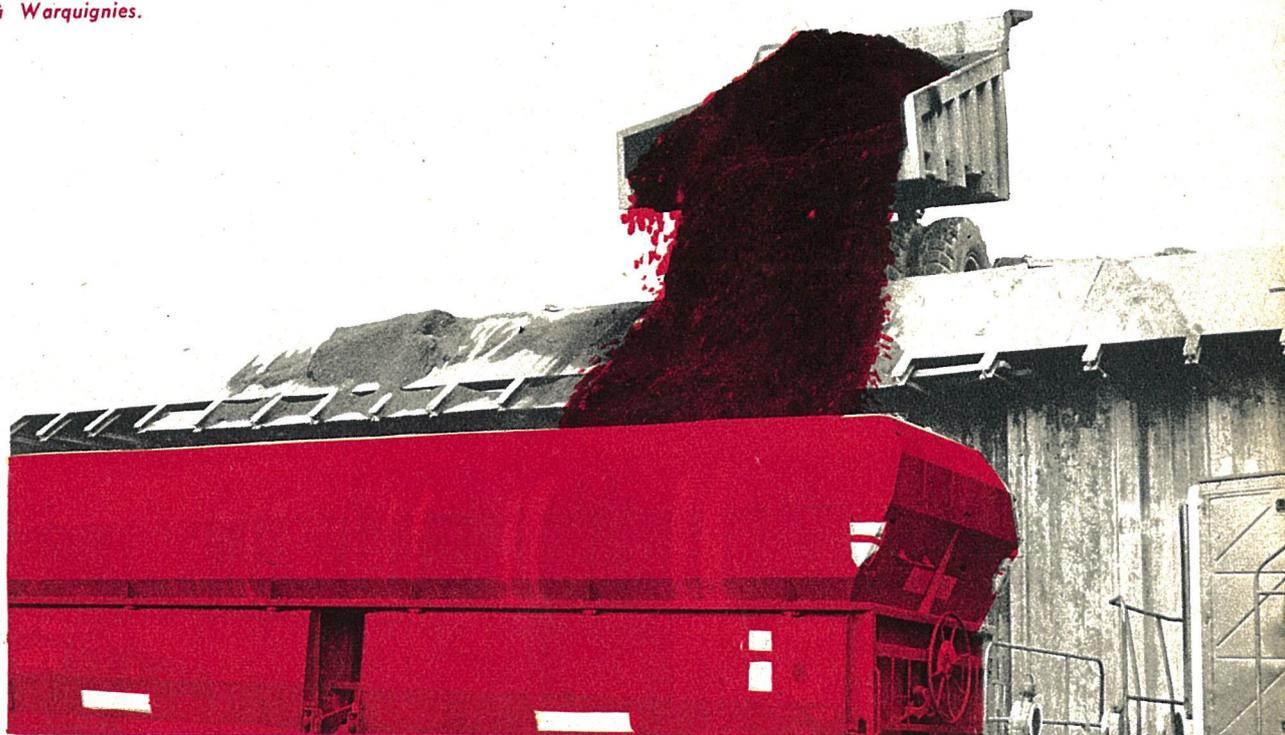
Le premier chantier de déchargement est situé entre Boussu et Hautrage, en bordure de la voie principale de Tournai vers Saint-Ghislain. Une voie a été posée sur un remblai ; le train sous charge est encadré de deux diesel qui amènent la rame à l'endroit prévu. Les wagons autodéchargeurs sont vidés les uns après les autres : le schiste tombe de part et d'autre de la voie, où il est repris par des bulldozers pour être rechargé dans des camions qui vont le déver-
