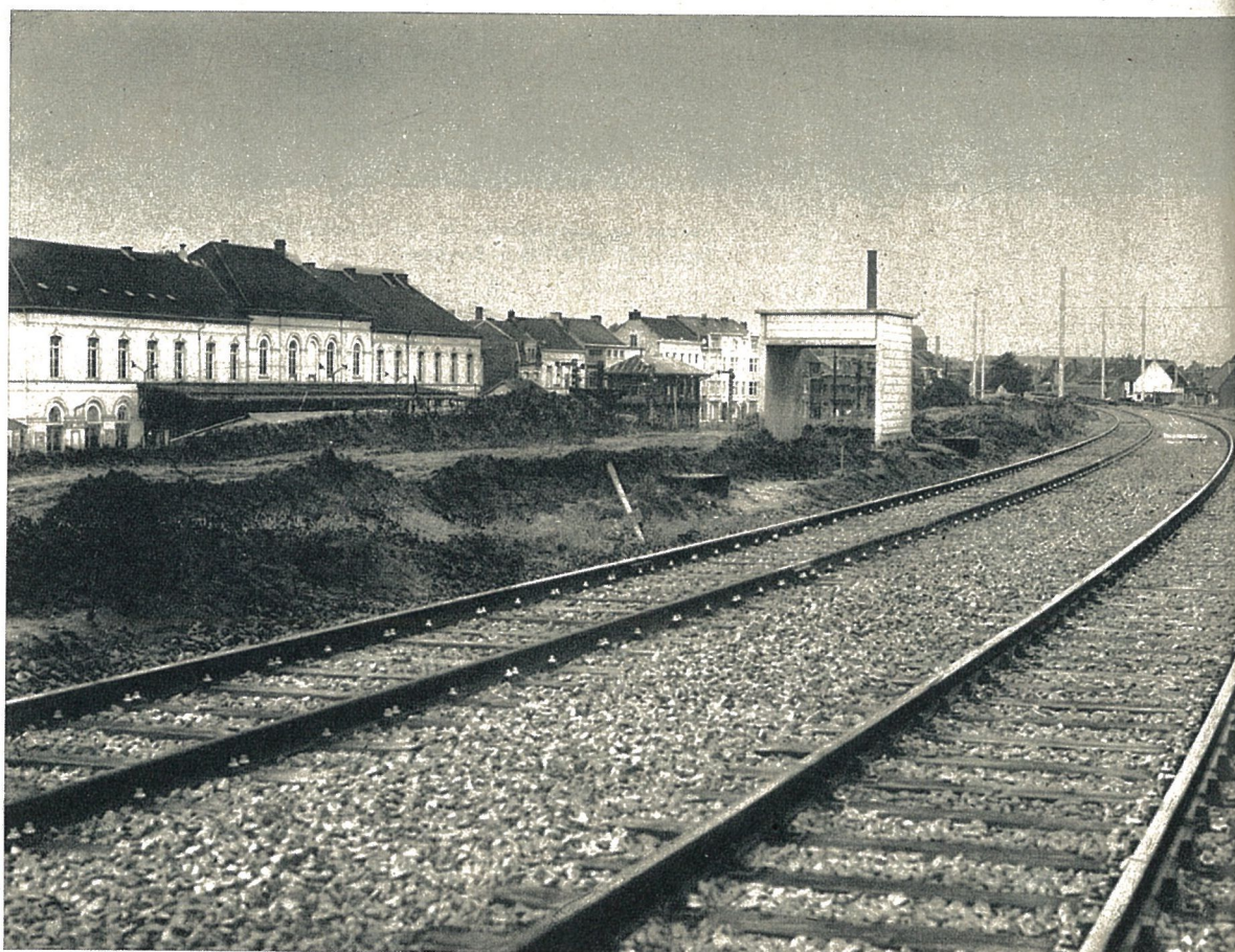
Aménagement de l'assiette de la nouvelle gare de Saint-Nicolas.
