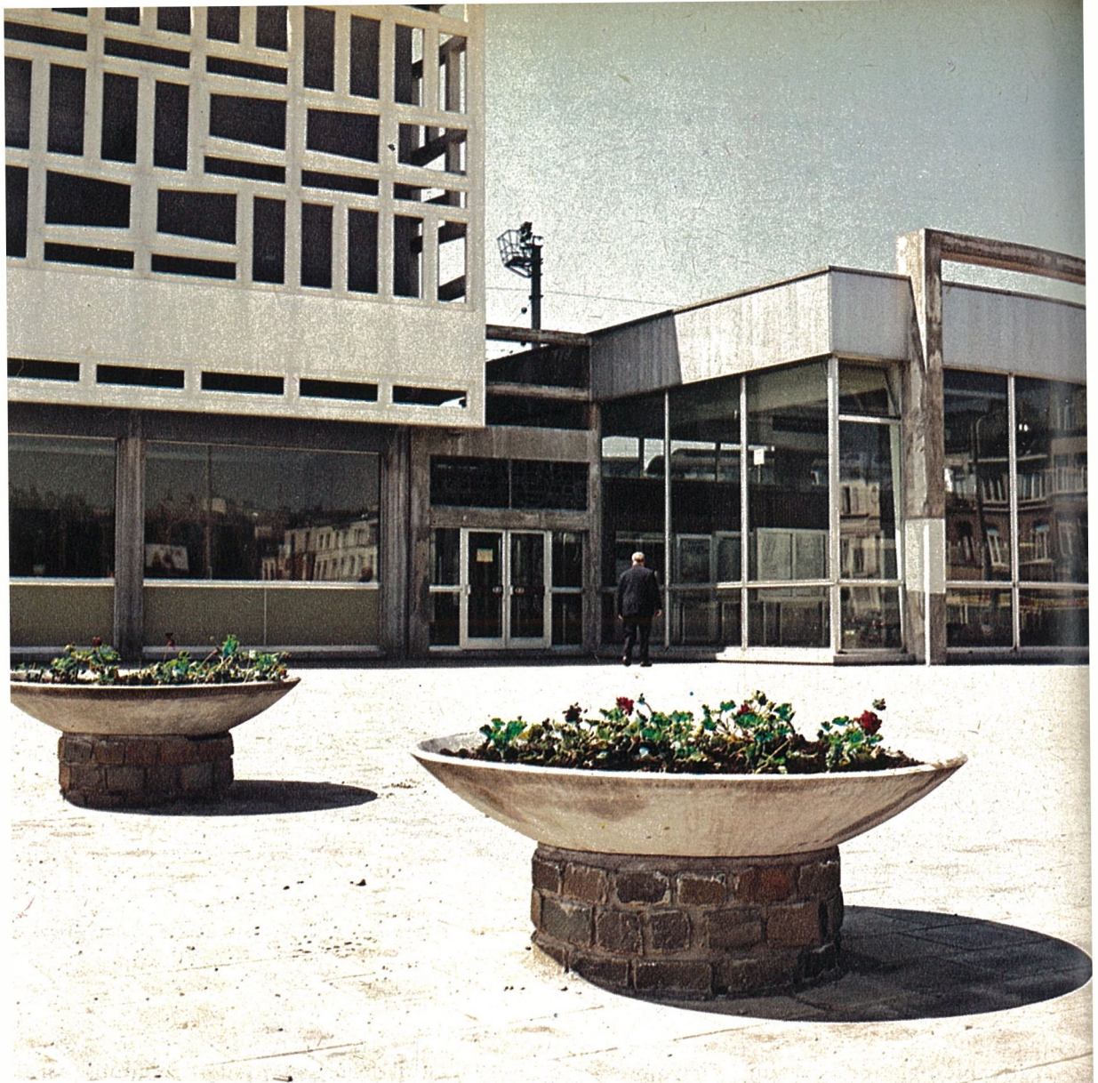
La nouvelle gare de Berchem.
