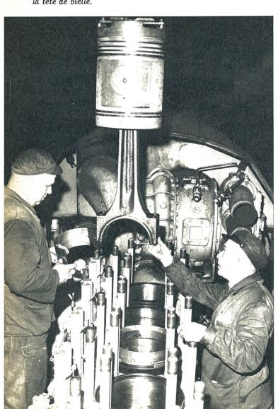
sur des fiches suiveuses. Une fiche de référence indique à partir de quelle valeur d'usure les pièces doivent être remplacées; dans ce cas, le remplacement se fait par des pièces approvisionnées à l'A.C. répartiteur (pièces reconditionnées ou pièces neuves).
