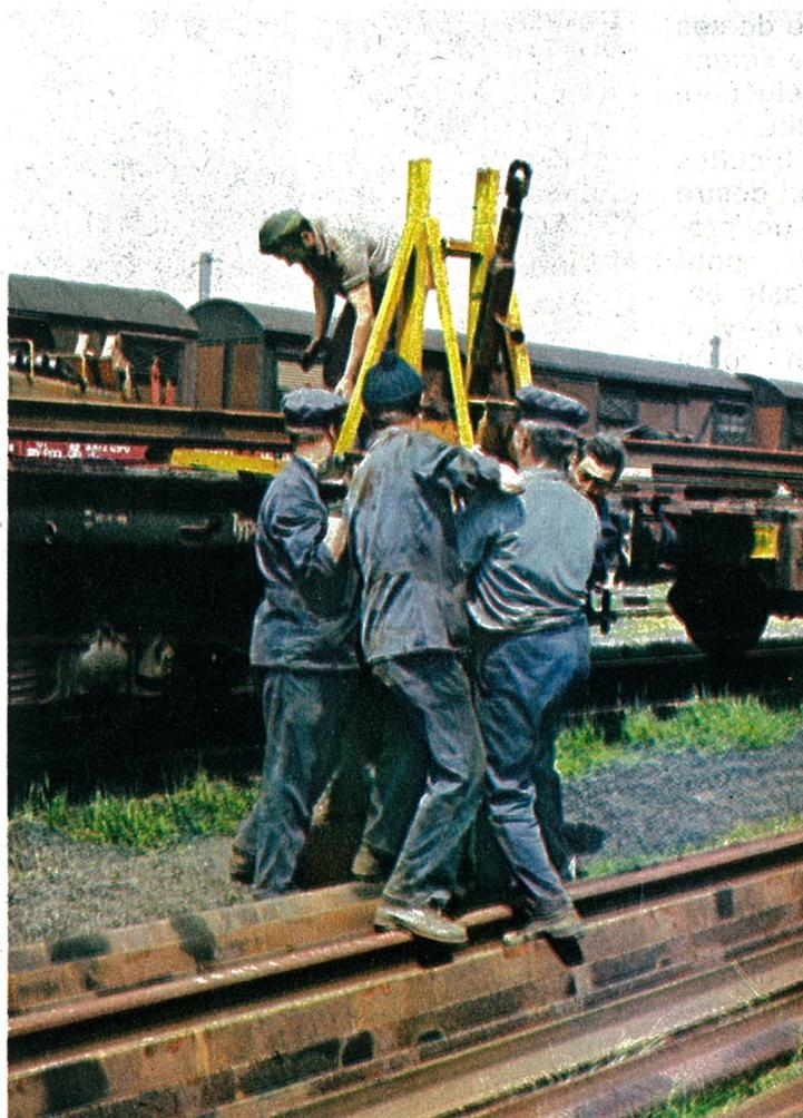
Le montage des portiques sur un wagon se réalise dans une gare avant le départ du train de route à destination du chantier. L'élément le plus encombrant et le plus pondéreux est le pied qu'il faut lever au niveau du plancher du wagon.
