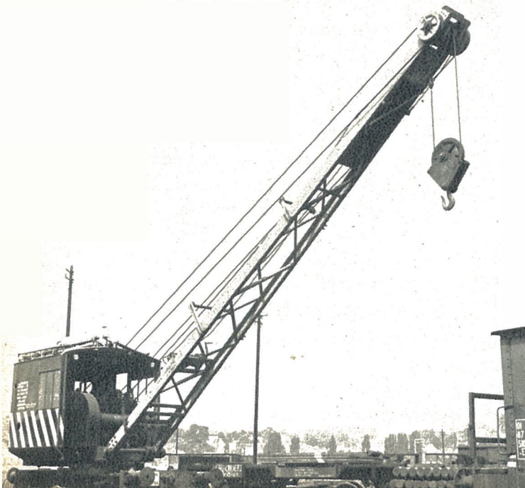
Fig. 6. Dieselkraan. Hefvermogen : 5 t.
