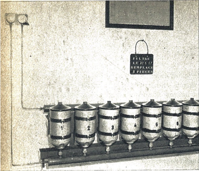
Fig. 3 a. Batterij van negen fijnfilters.
