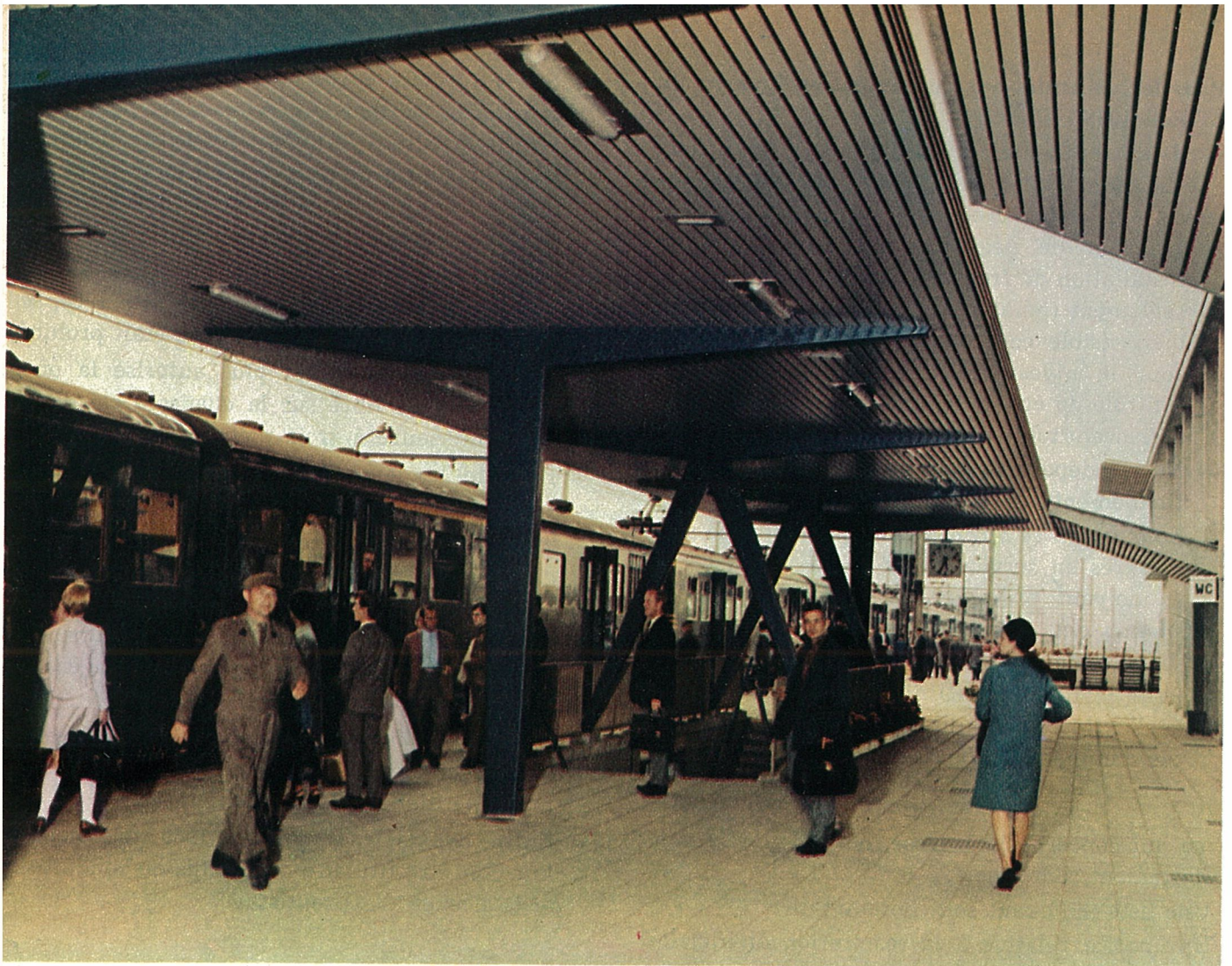
Sous de nouveaux perrons, avec revêtement en aluminium prélaqué (photo J.L. Piek © Hunter Douglas).
