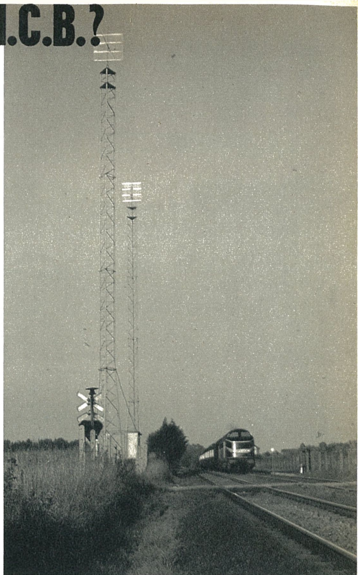
Station-relais de Bierghes-lez-Hal pour liaisons « radio » avec les trains en ligne.
