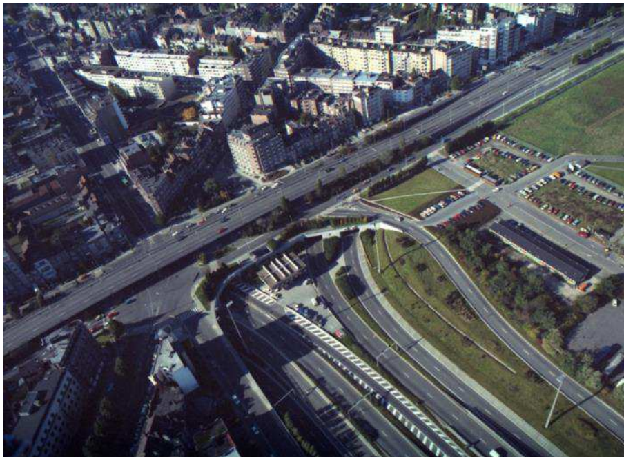
Vue aérienne de l'autoroute E40 et du viaduc du boulevard Auguste Reyers, 1982 (Régie des Bâtiments, 129220).
