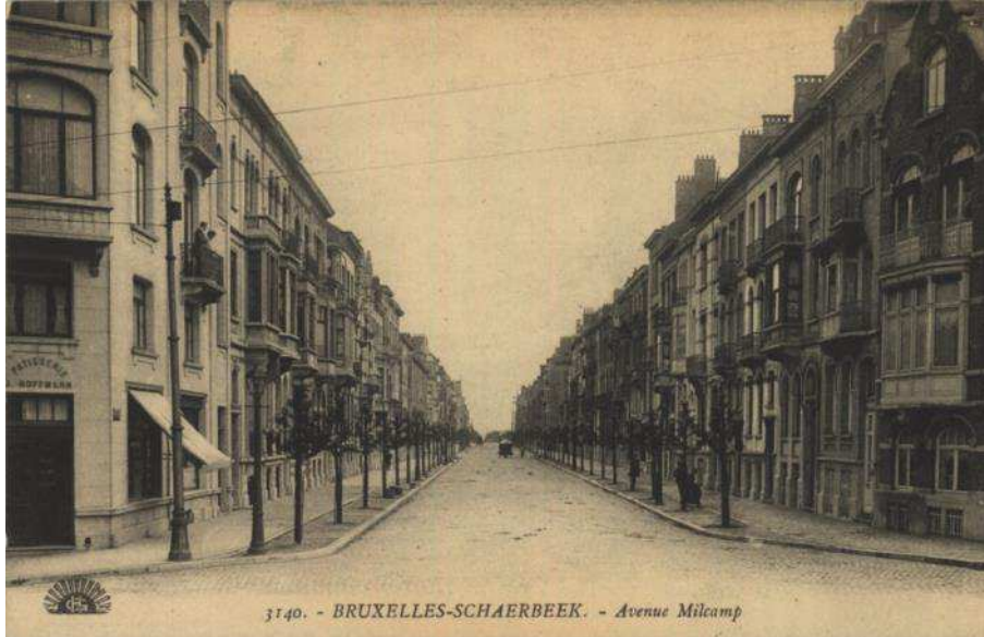
Avenue Milcamps, vue depuis la rue du Noyer (AVB/CP).
