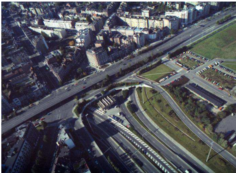
Luchtfoto van de E40-autosnelweg en het viaduct van de Auguste Reyerslaan, 1982 (Regie der Gebouwen, 129220).
