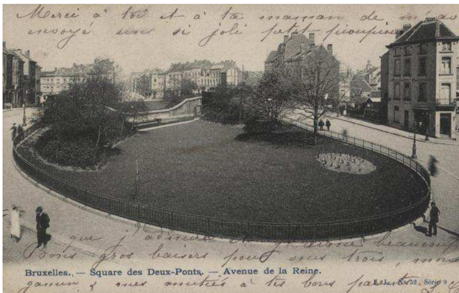
Zicht op de twee viaducten van de Koninginnelaan over de spoorweg van het Noordstation (ASB/CP).
