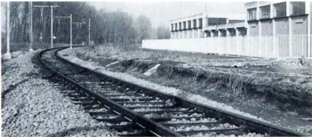
la sous-station de traction de Willebroek
