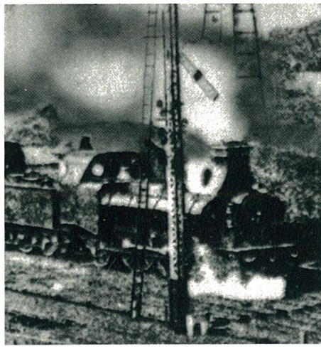
1. Cabine Siemens 2. Sémaphore d'inspiration anglaise, la palette inférieure est inclinée à 45° (ralentissement) : ligne Bruxelles-Gand
