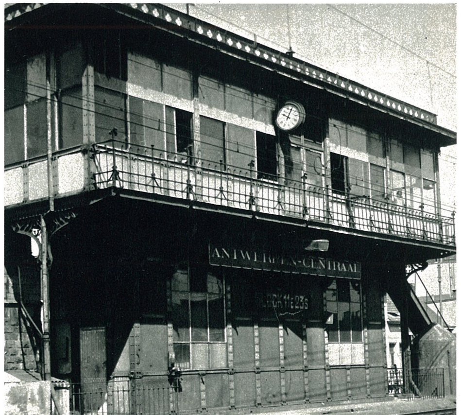
4. Anvers Central : première cabine Siemens électrique
