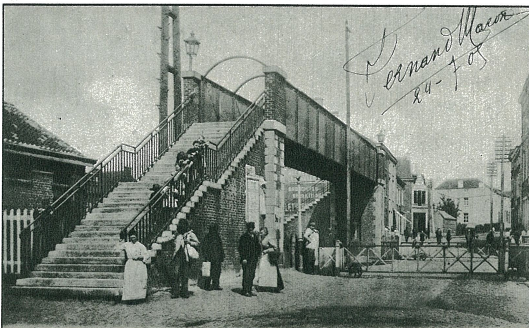
Jumet Overbruggingen, zoals deze van een hekwerk voorzien en voor voetgangers bestemde constructies, overspannen vaak de spoor- weginstallaties.
