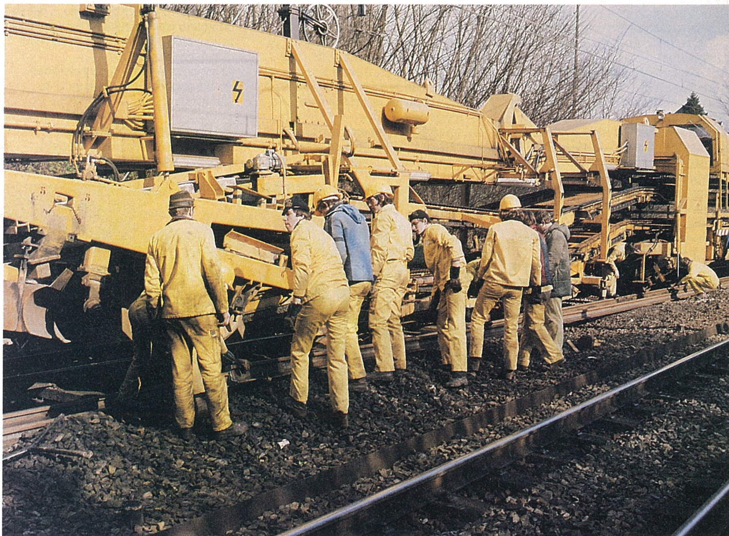
train de renouvellement ▲
