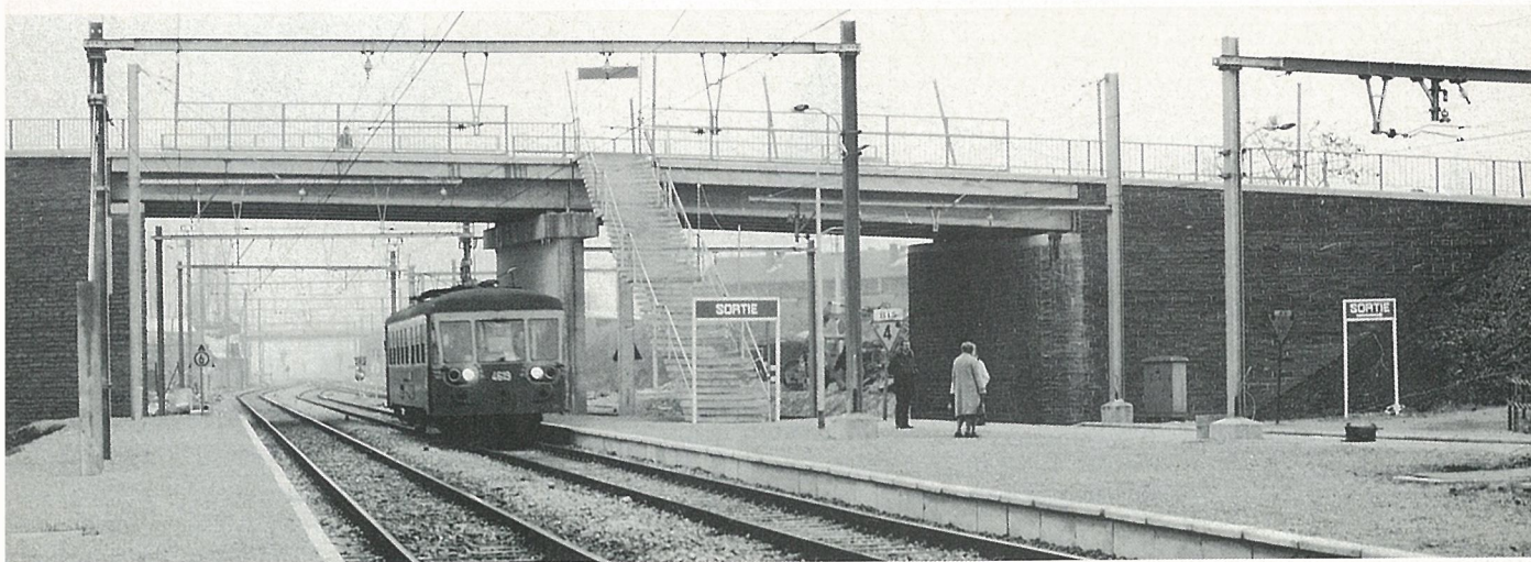
le nouveau pont de Haine-Saint-Pierre
