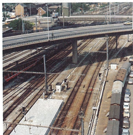
du haut de la tour, vue plongeante du complexe ferroviaire et routier côté Bruxelles
