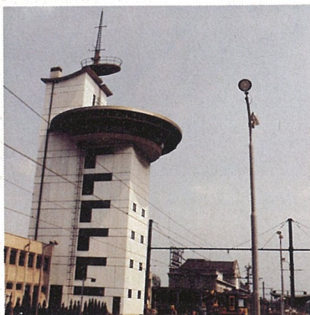
vue extérieure du block 20 de Charleroi Sud
