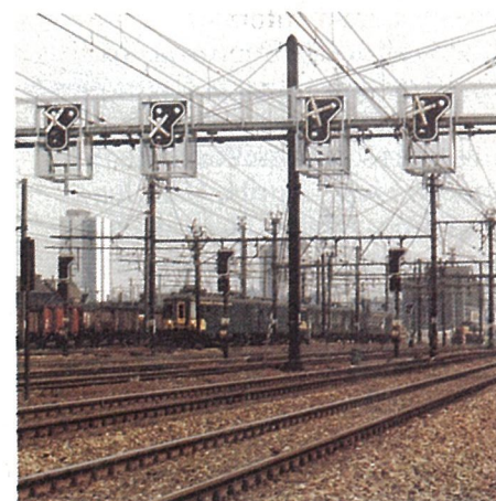
passerelle pour signaux d'entrée de la gare de Charleroi Sud côté Bruxelles, en cours de montage
