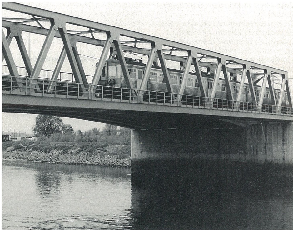
Het eerste elektrisch motorstel dat tijdens een proefrit over de nieuwe Scheldebrug rijdt.
