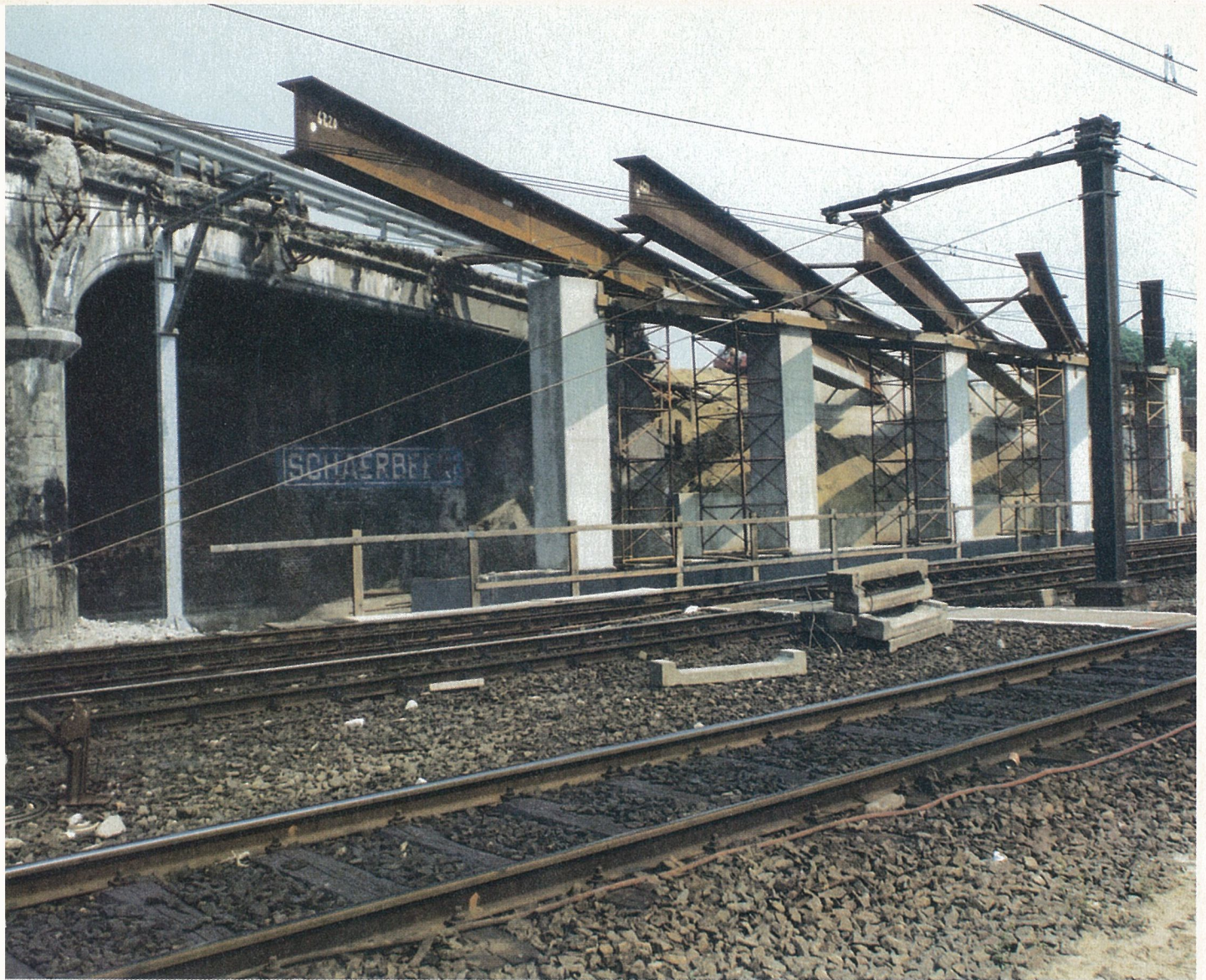
vue d'une série de poutres posées et détail de l'ancien pont
