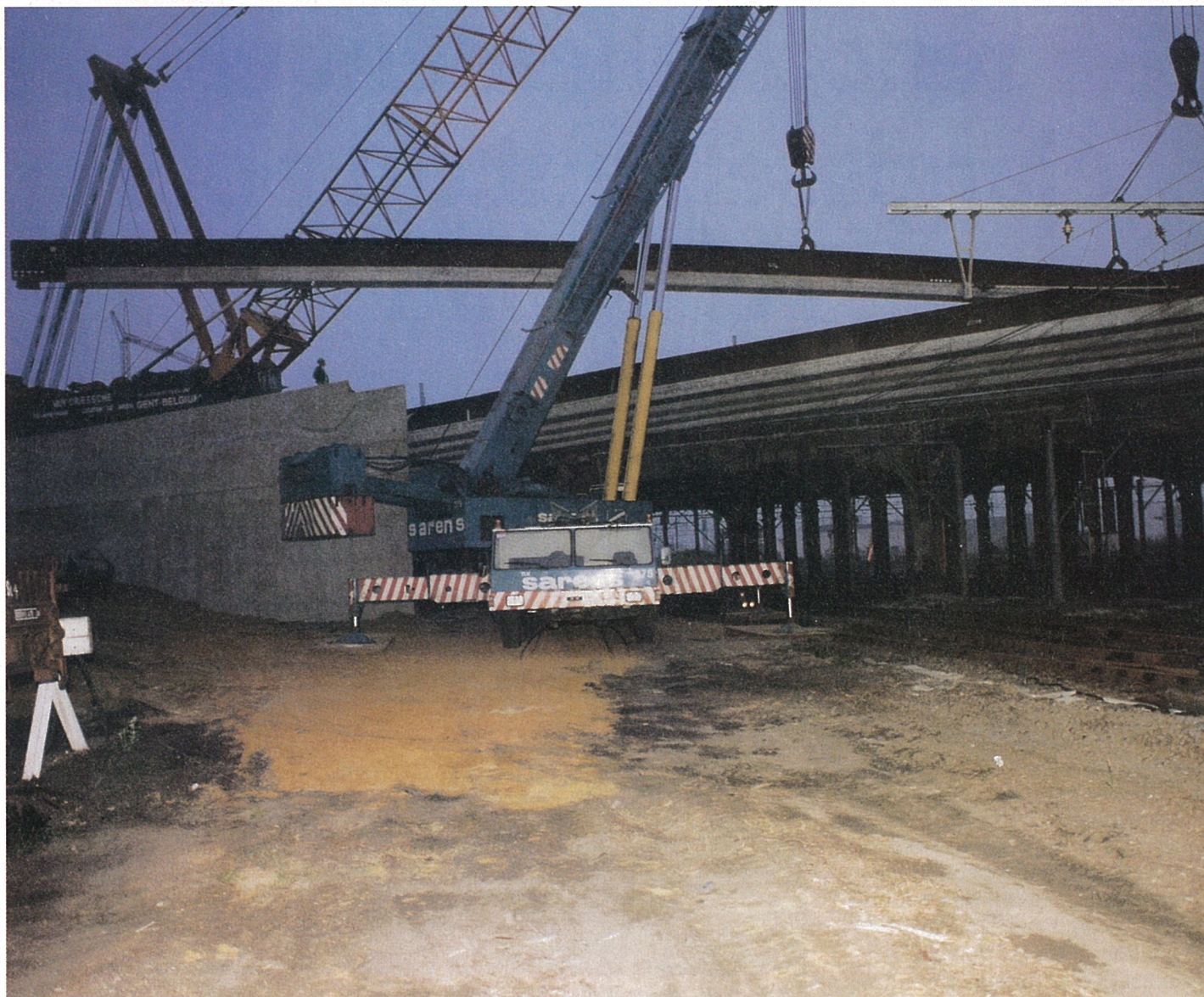
pose de poutres avec utilisation de deux grues travaillant en synchronisation
