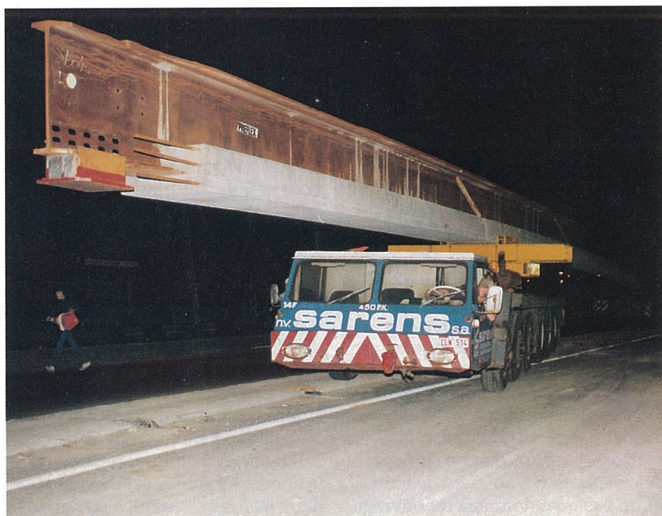
préparation d'une poutre préfêlée à poser
