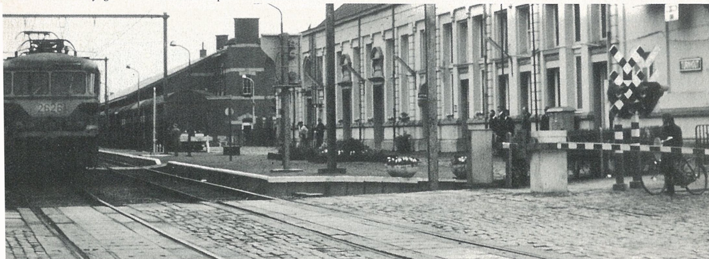
Vue du bâtiment voyageurs de Turnhout, depuis la Merodelei
