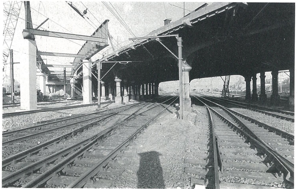
Het ineenzetten van de metalen brug met gezicht op de oude brug.
