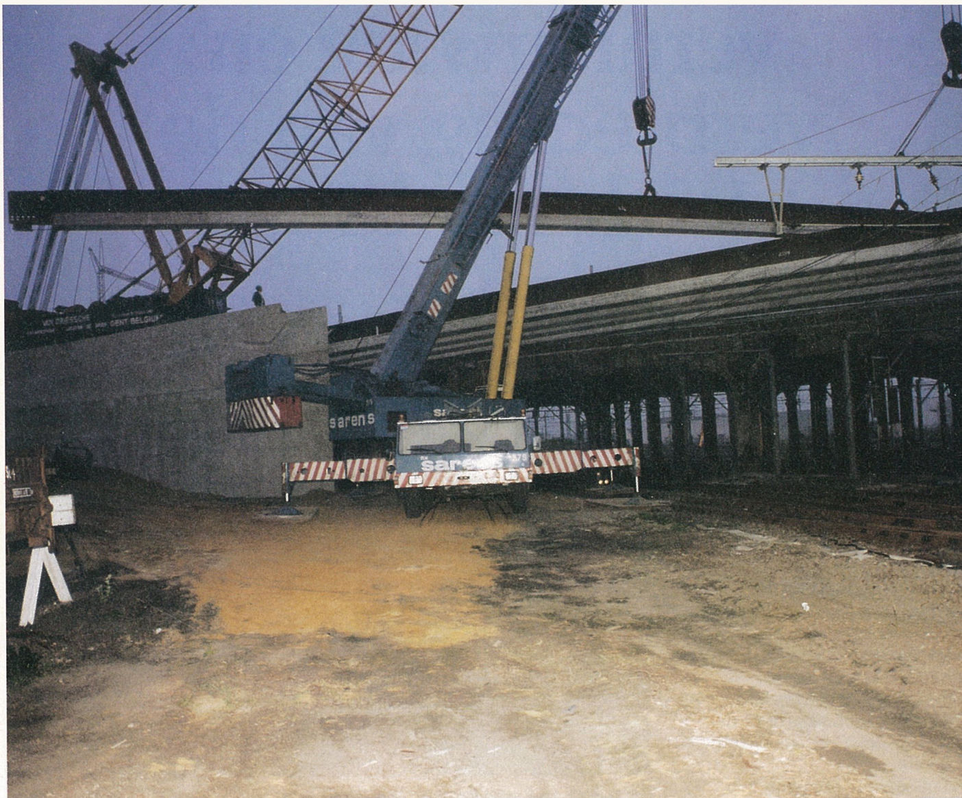
Het plaatsen van liggers met twee synchroon werkende kranen.
