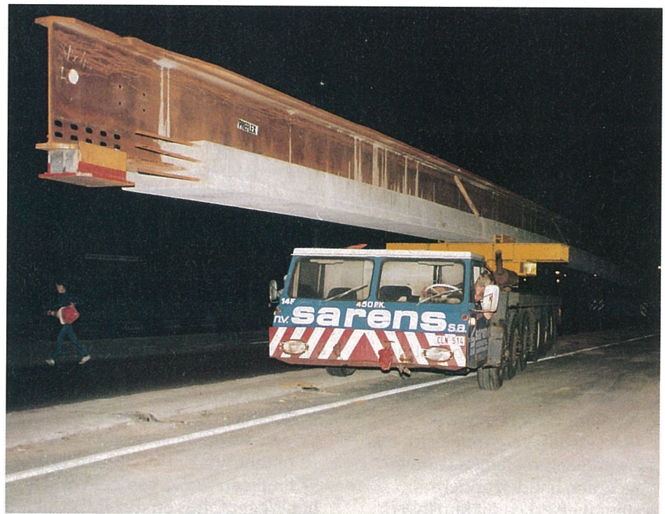
Het klaarmaken, voor de plaatsing, van een voorgebogen ligger.
