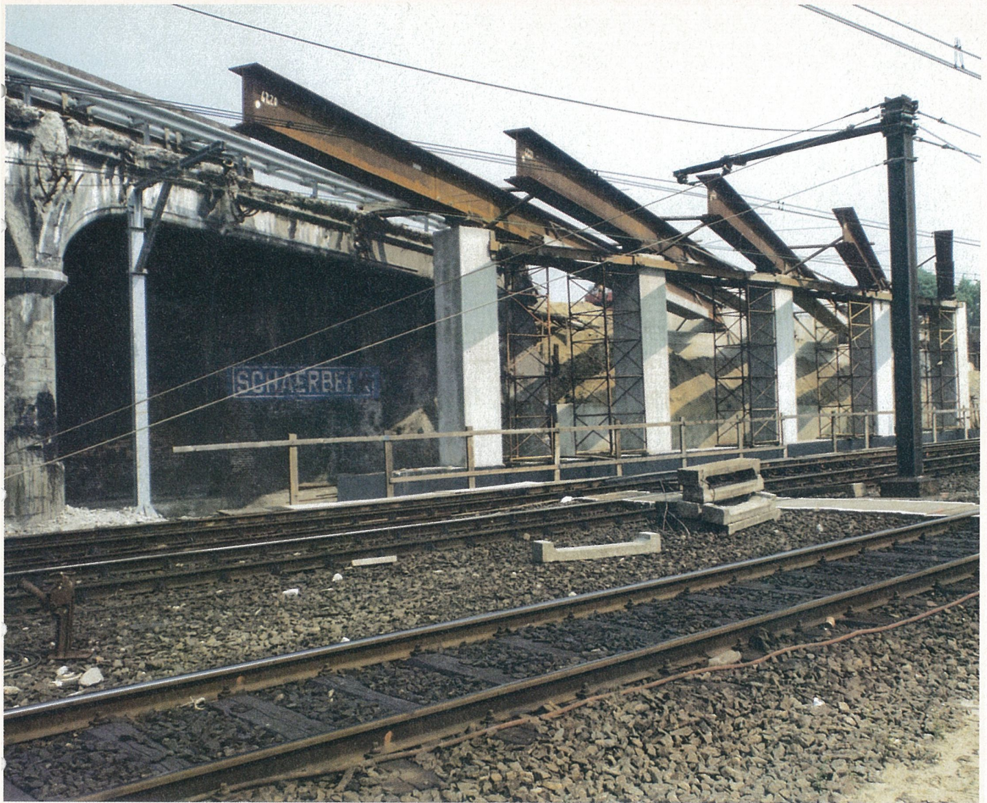
Gezicht op een reeks geplaatste liggers en details van de oude brug.
