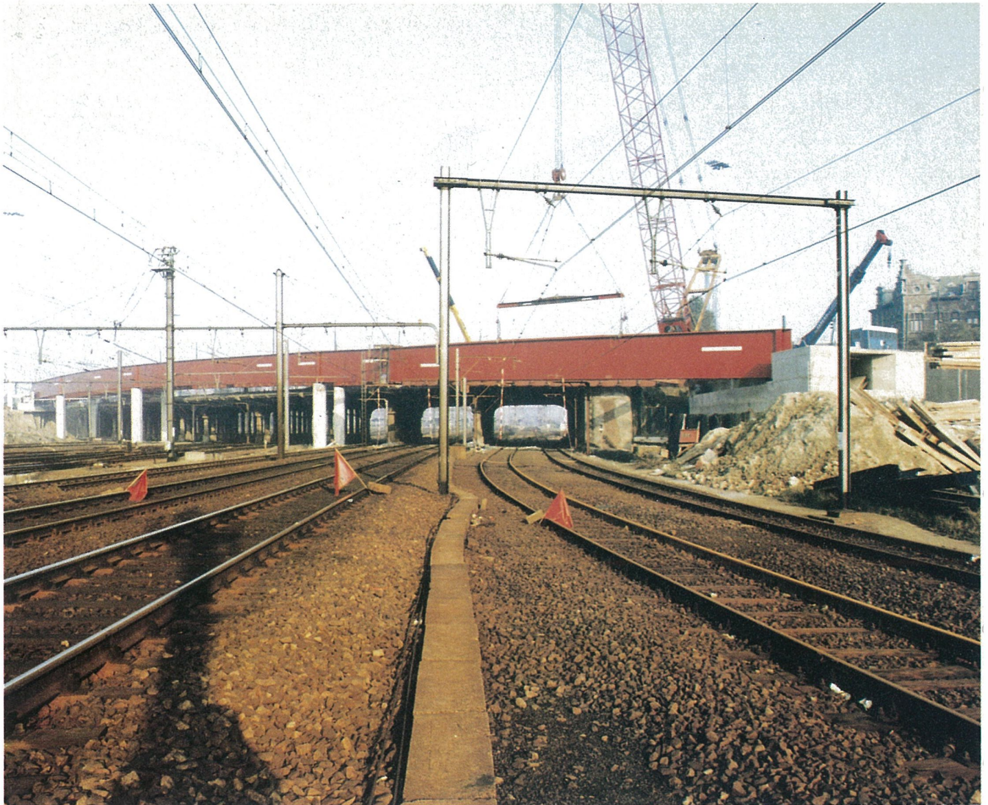
Gezicht op de werken richting Schaarbeek : de metalen brug voor trams en zwaar verkeer.
