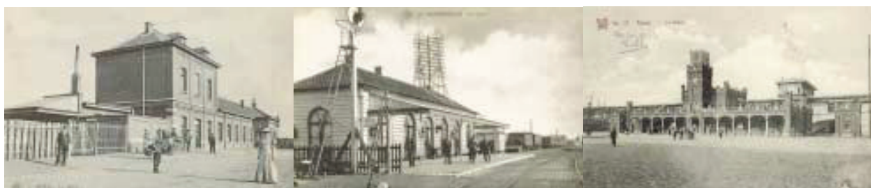
▲ Geel Typisch station van de Grand Central Belge .
