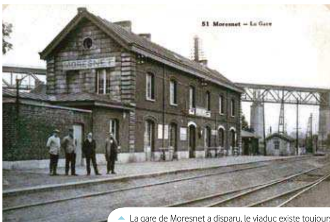
▲ La gare de Moresnet a disparu, le viaduc existe toujours
