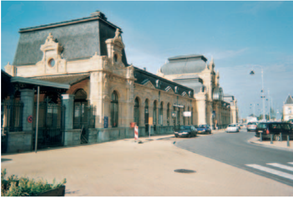
▲ La gare d'Arlon
