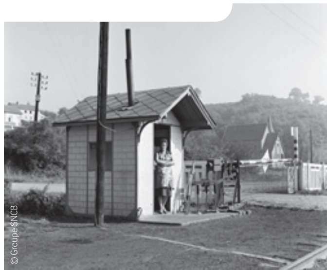
▲ Garde-barrière à Java, sur la ligne 125 « Liège-Palais - Namur »
