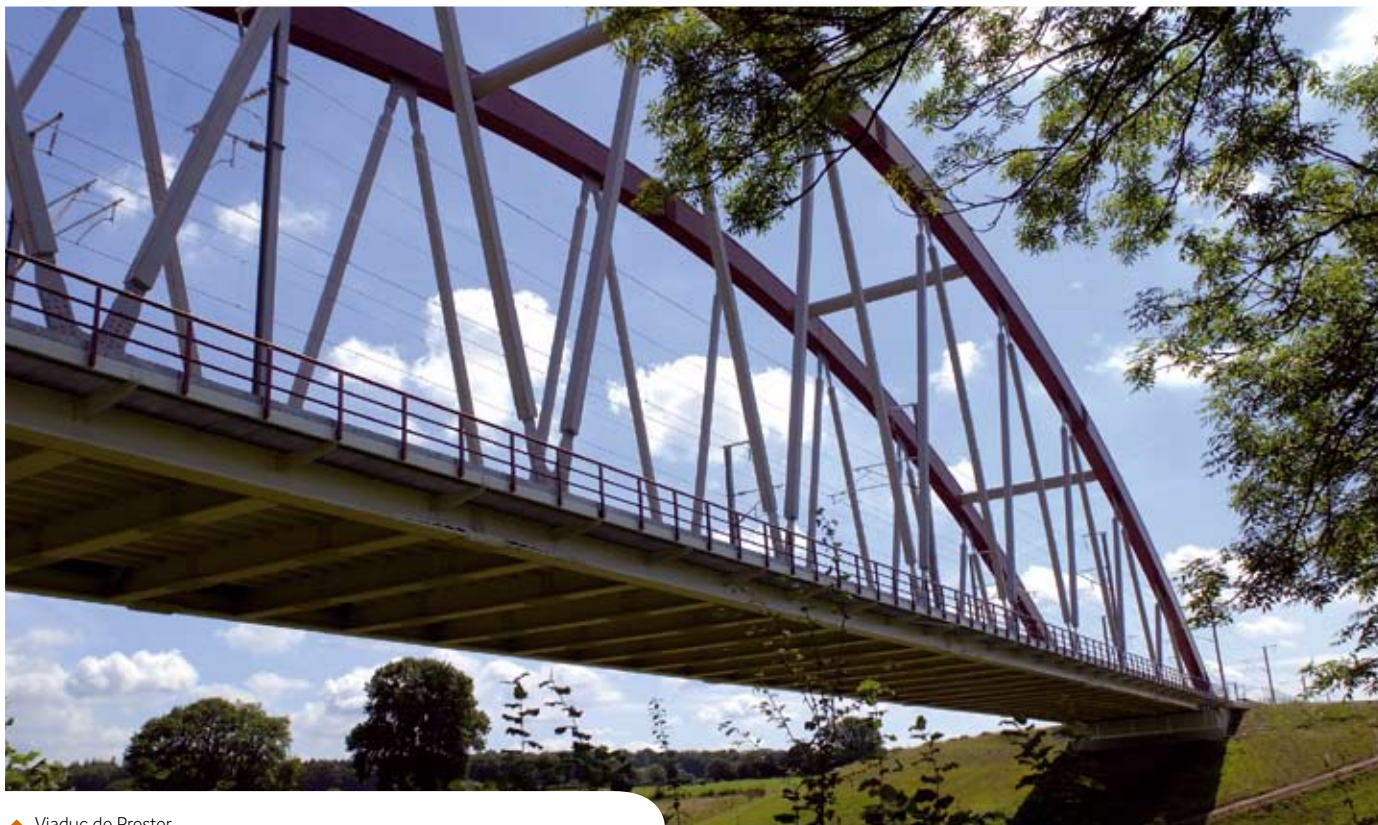
▲ Viaduc de Prester
