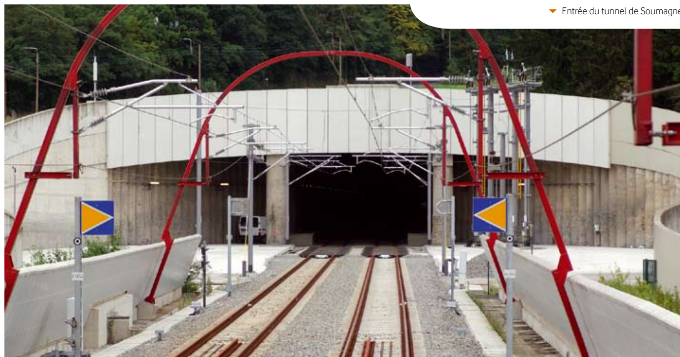
▼ Entrée du tunnel de Soumagne
