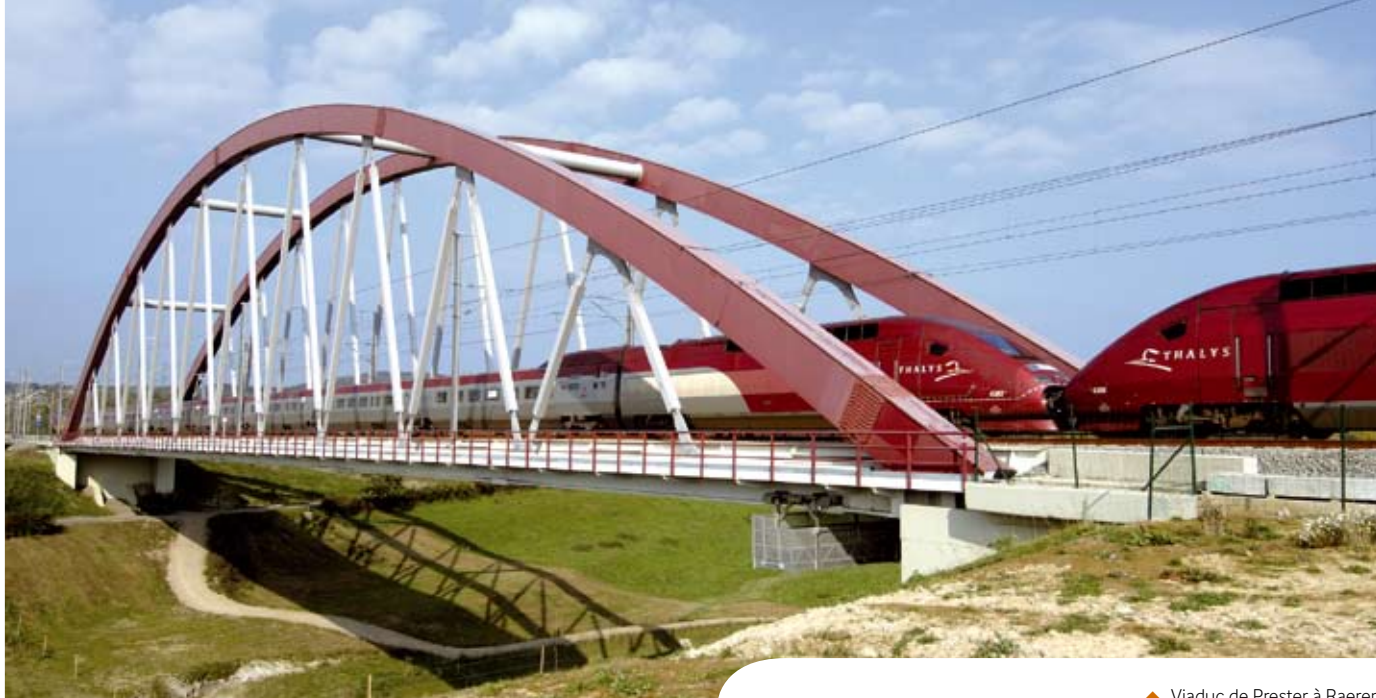
▲ Viaduc de Prester à Raeren
