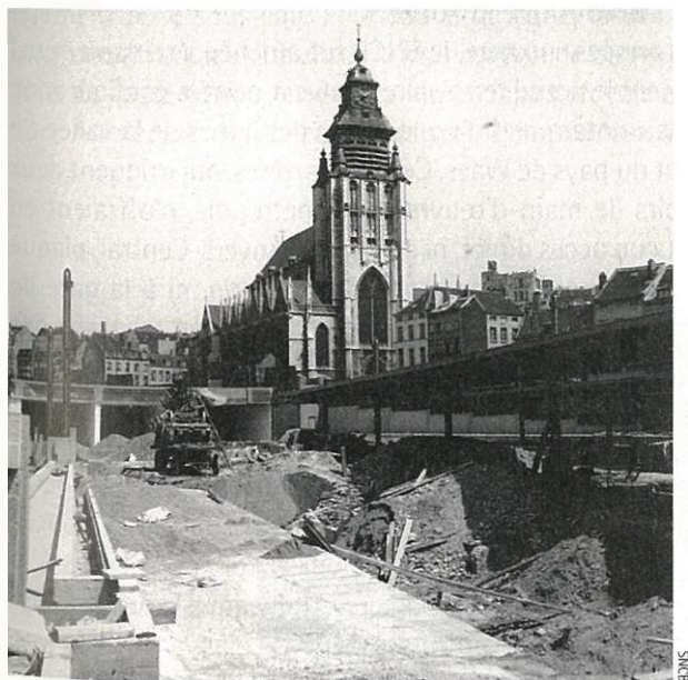
▲ Travaux de la jonction Nord-Midi
