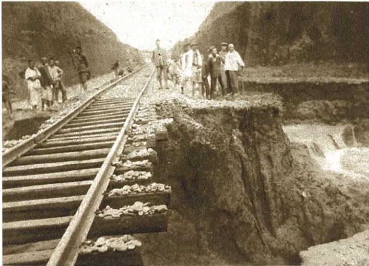
Chine: Ligne de Pien-lo, dégâts causés par les pluies torrentielles. China: Lijn van Pien-lo, schade aangericht door de stortregens.
