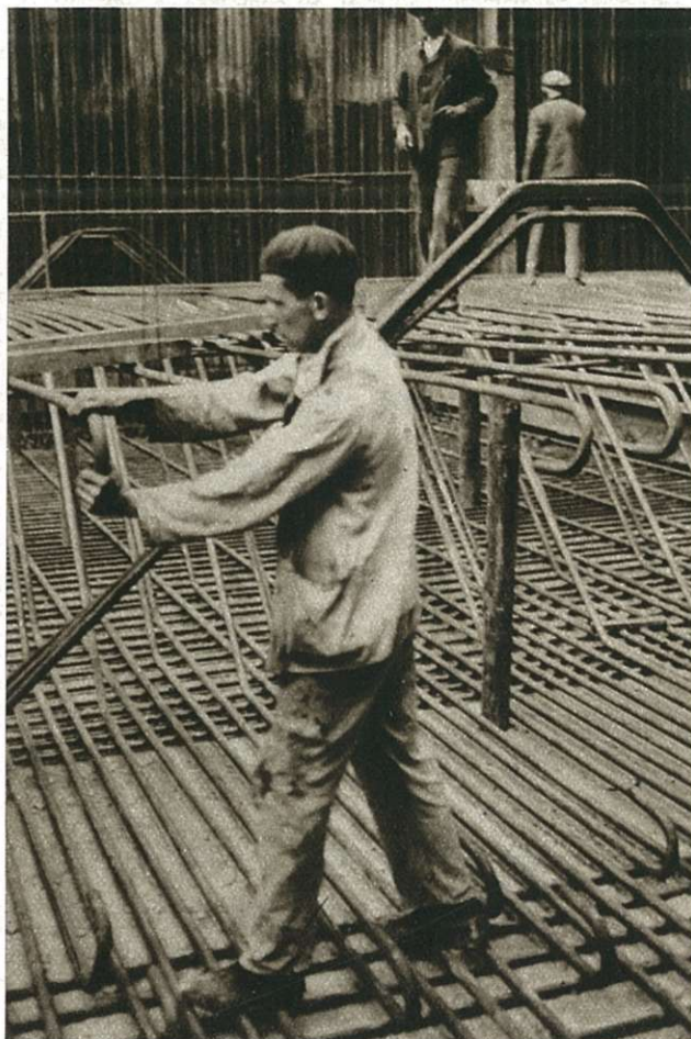
Fig. 23. — Pose des fers du radier du tunnel — 1er tronçon.
