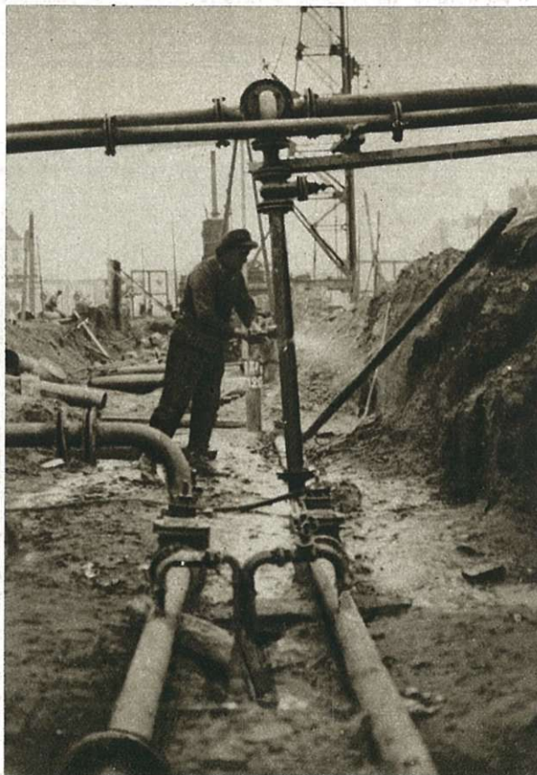
Fig. 4. — Tuyauteries de pompage pour le rabattement de la nappe aquifère.
