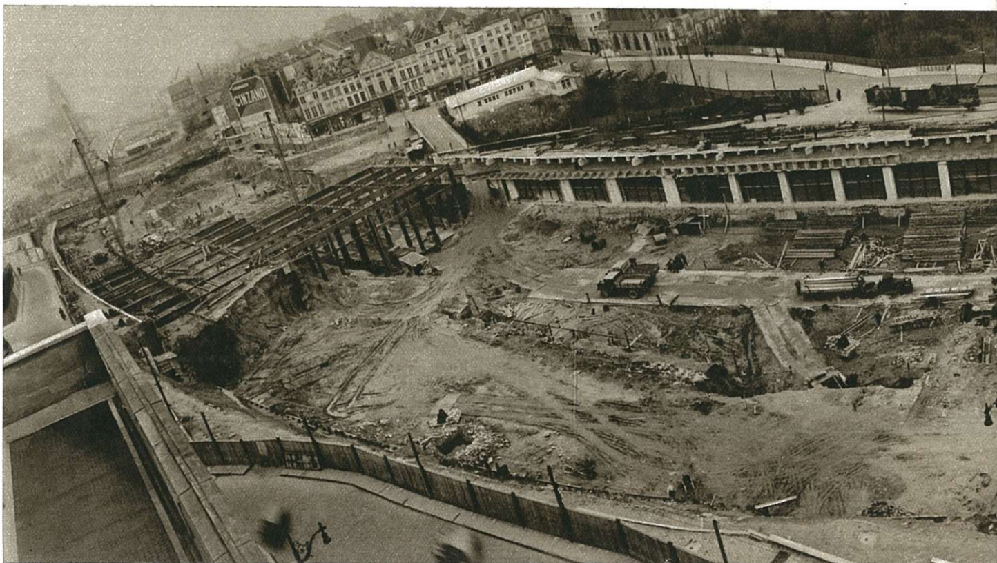
Fig. 28. — Vue d'ensemble du chantier du 2 me tronçon. Il s'agit de la construction de la gare Centrale (arch. Victor Horta) dont les voies ont un tracé courbe. A la date du 16 décembre 1938, les rideaux de palplanches étaient en place, le garage de la ville (visible au centre) était sectionné et le rabattement de la nappe aquifère amené à la cote la plus basse. Aux abords du Mont-des-Arts, cette cote atteignait 12 m. sous le niveau normal de la nappe.
