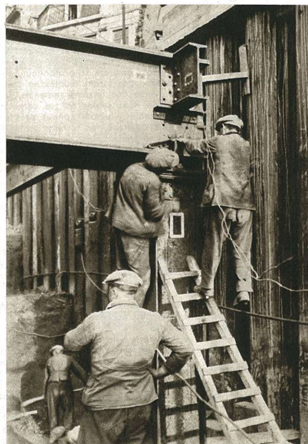
Fig. 6. — Mise en place d'une poutre transversale du système d'étaie métallique — 1 er tronçon du tunnel.
