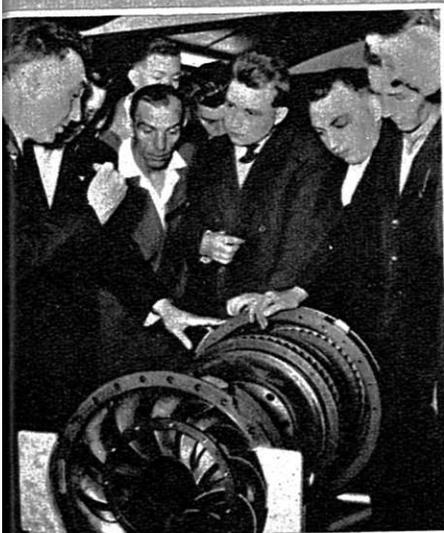
*Stator d'un transformateur de couple.*
