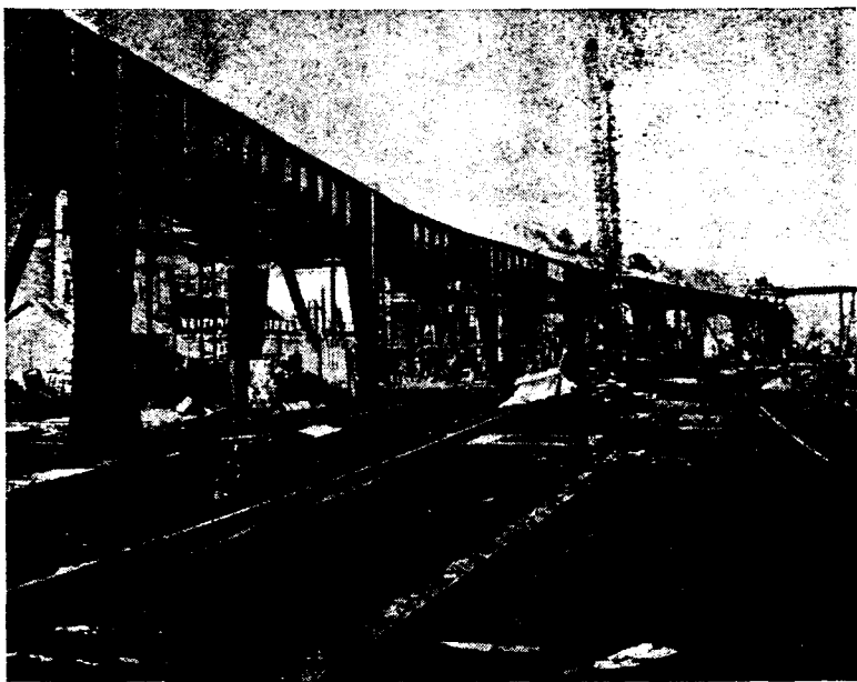
BRUSSEL-ZUID. — Goederenloods (kant Frankrijkstraat). Opstelling van de metalen krukpijlers.
