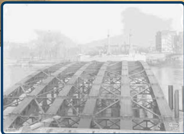
Reconstruction du pont de Fragnée, après sa destruction durant la Seconde Guerre mondiale, par Cockerill © MMIL-CMI
