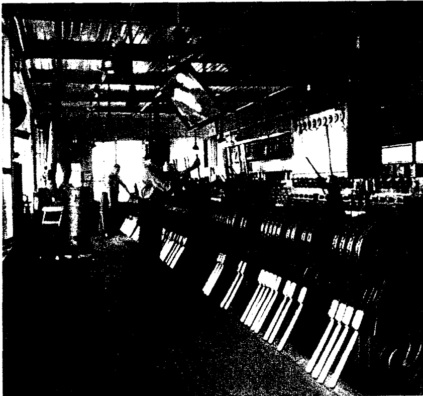
Een Siemens-seinhuis te Vorst-Zuid.
