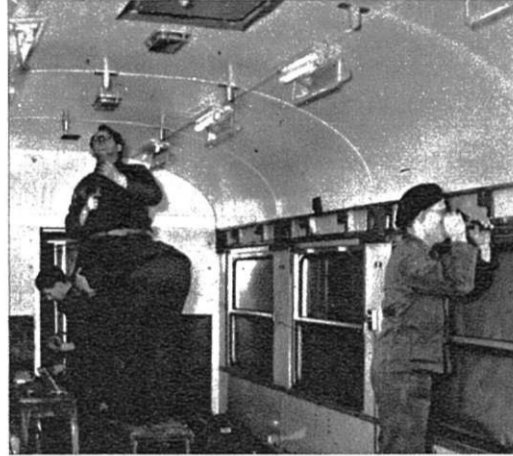
Plaatsen van de binnenbekleding, proef van verlichting en opstellen van de luchtgevers.
