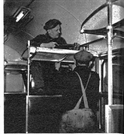
Opstellen van pakkenrekken.
