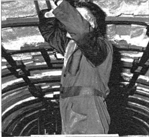
Plaatsen van de glaswolisolering.
