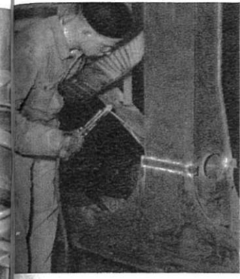
4. Een lasbewerking op het freem in verticale stand.
