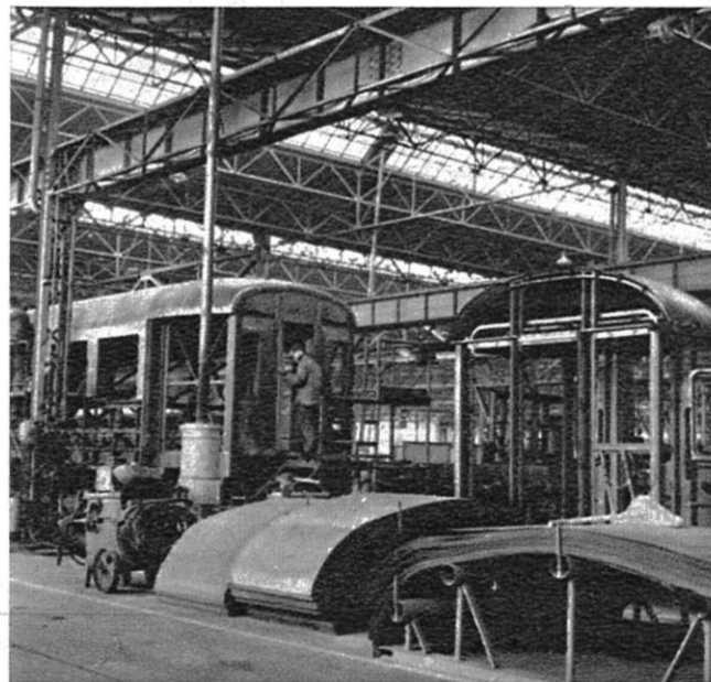
Een zicht op de hoofdketting voor de ruwbouw.
