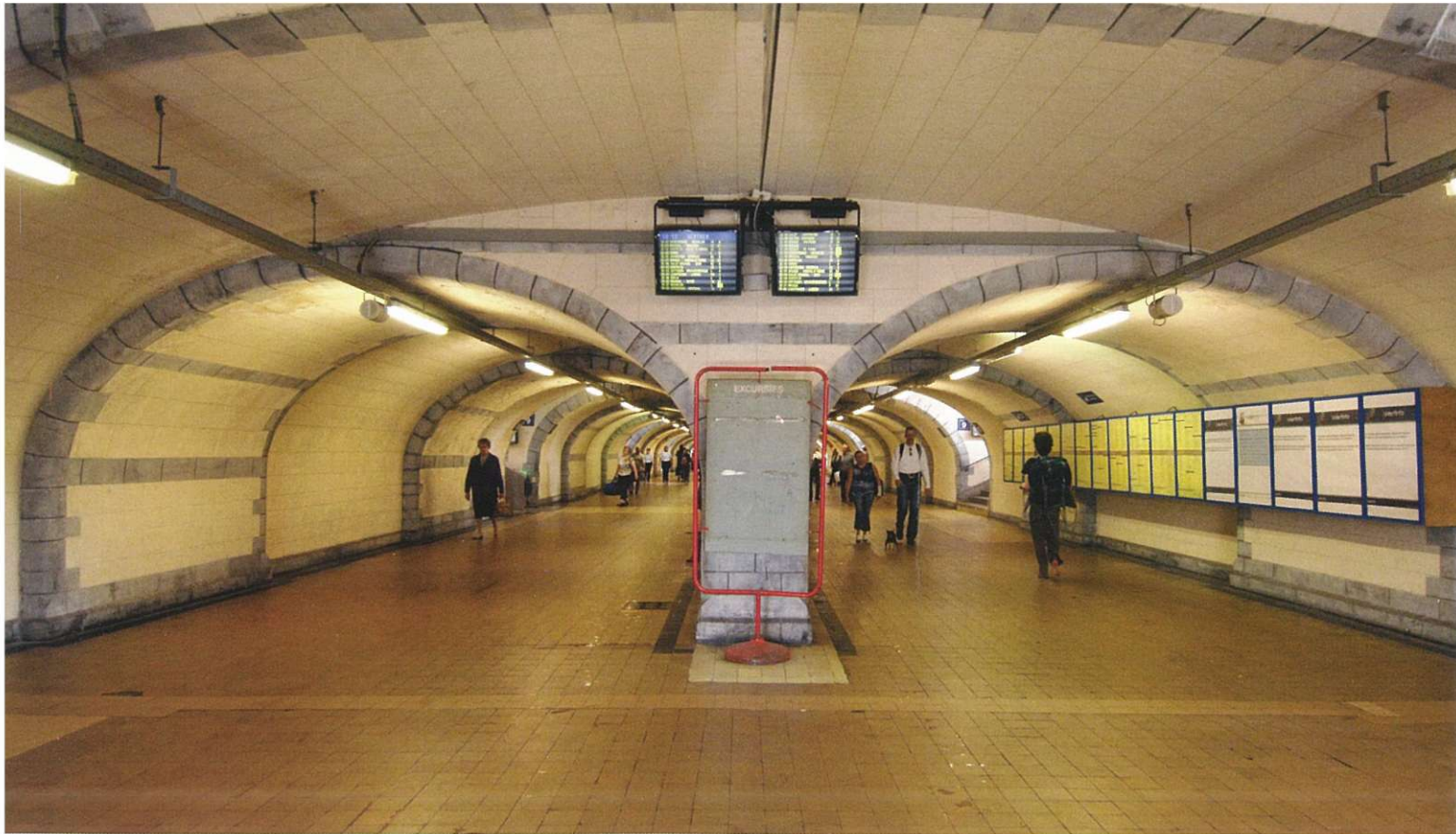
De huidige onderdoorgang.
