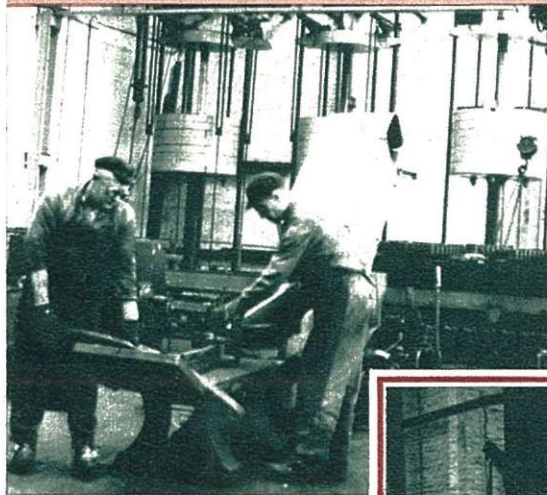
Débridage des ressorts et visite des lames. Dans le fond : les trois accumulateurs.
