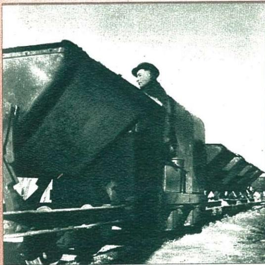
*Le train des wagonnets Decauville chargés de béton frais.*
