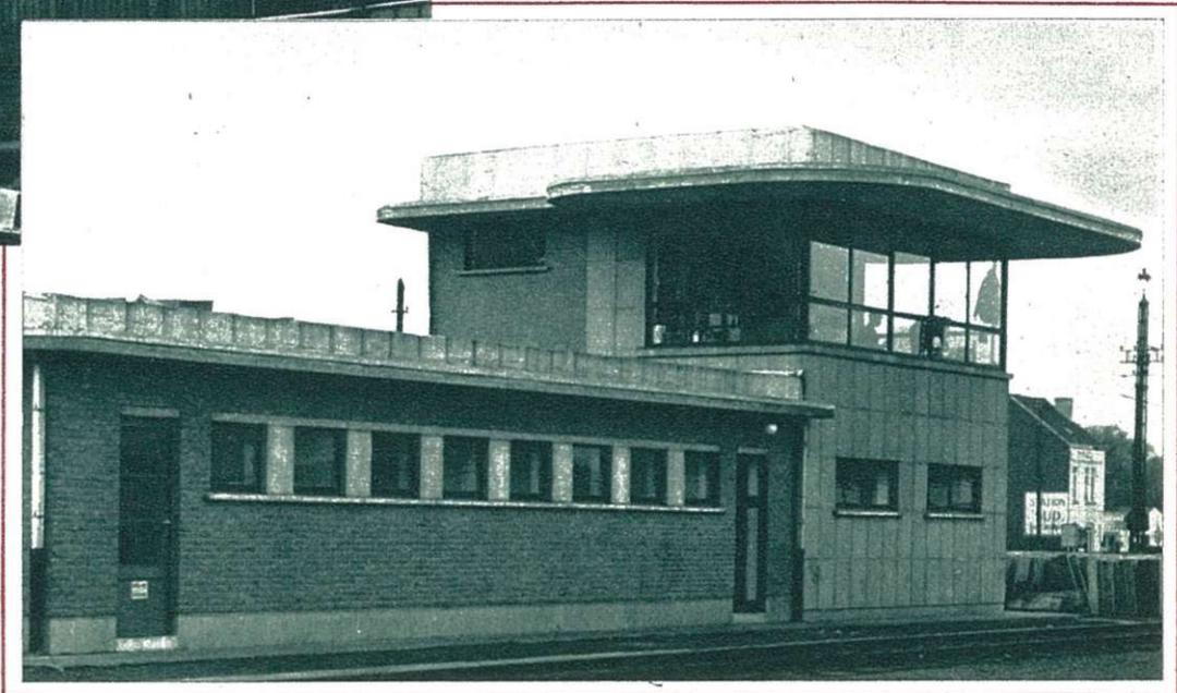
une cabine électrique, sans enclenchements mécaniques, dans laquelle toutes les conditions de sécurité sont réalisées exclusivement par des relais électriques.
