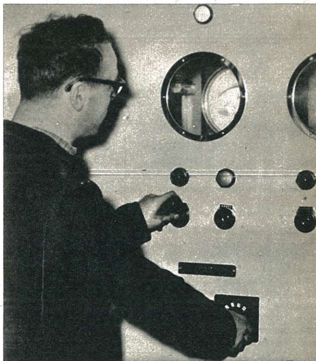
Contrôle de l'équipement électrique dans un atelier
