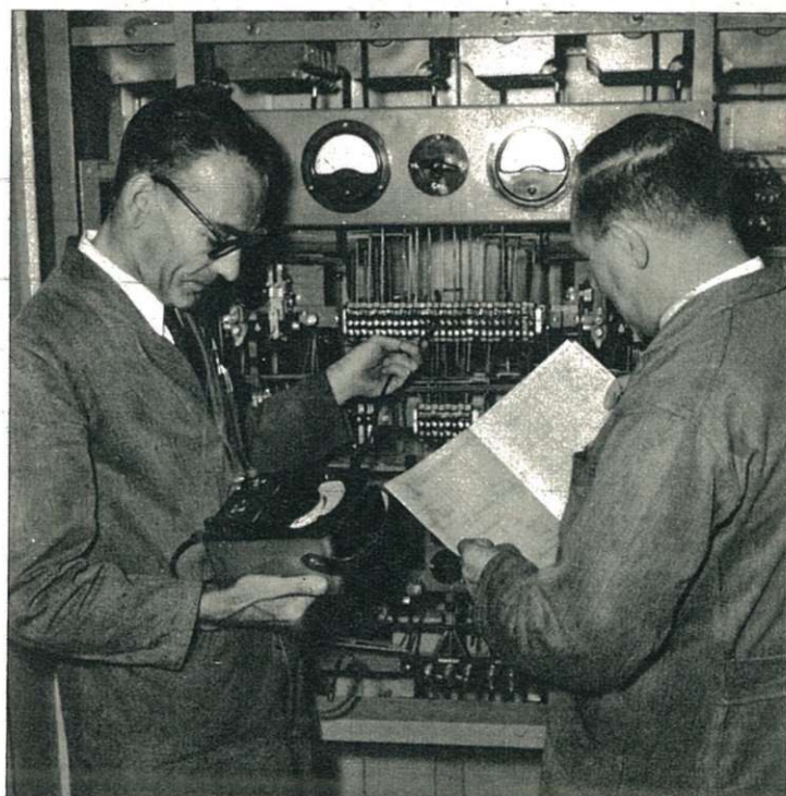
Le contremaître et le chef électromécanicien effectuant des mesures à l'appareillage du redresseur de courant 48 V.
