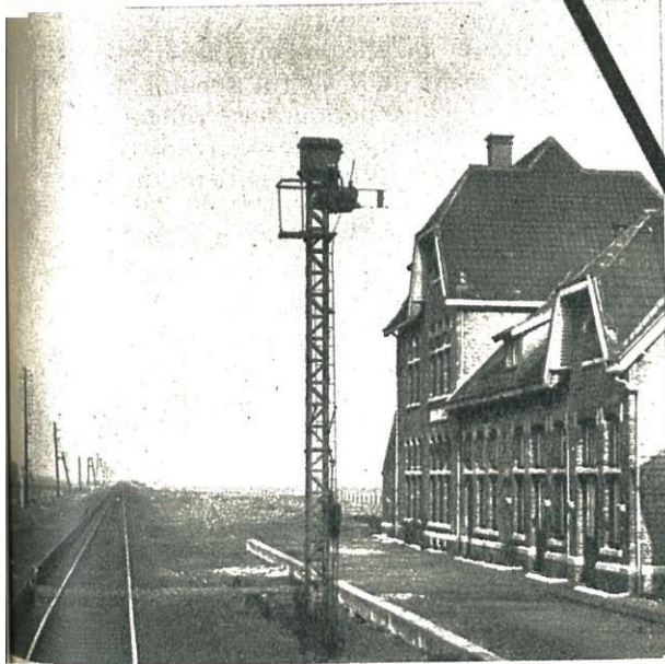
Gare de marchandises la moins élevée : Oostkerke, sur la ligne 74. Cote rail : 2,49 m.
