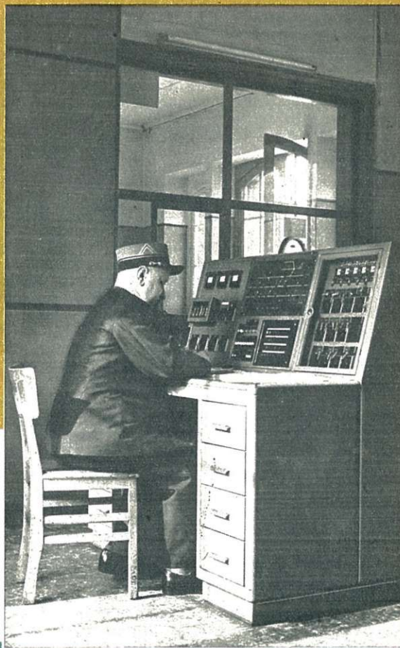
Le poste « tout relais » de Trooz raccordé à la CCC, desservi localement pour les manœuvres en gare.
