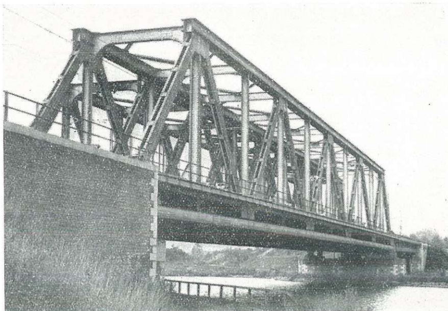
Fig. 14. — Brug over het kanaal van Brussel naar Charleroi in de geëlectriceerde lijn Brussel-Charleroi.
