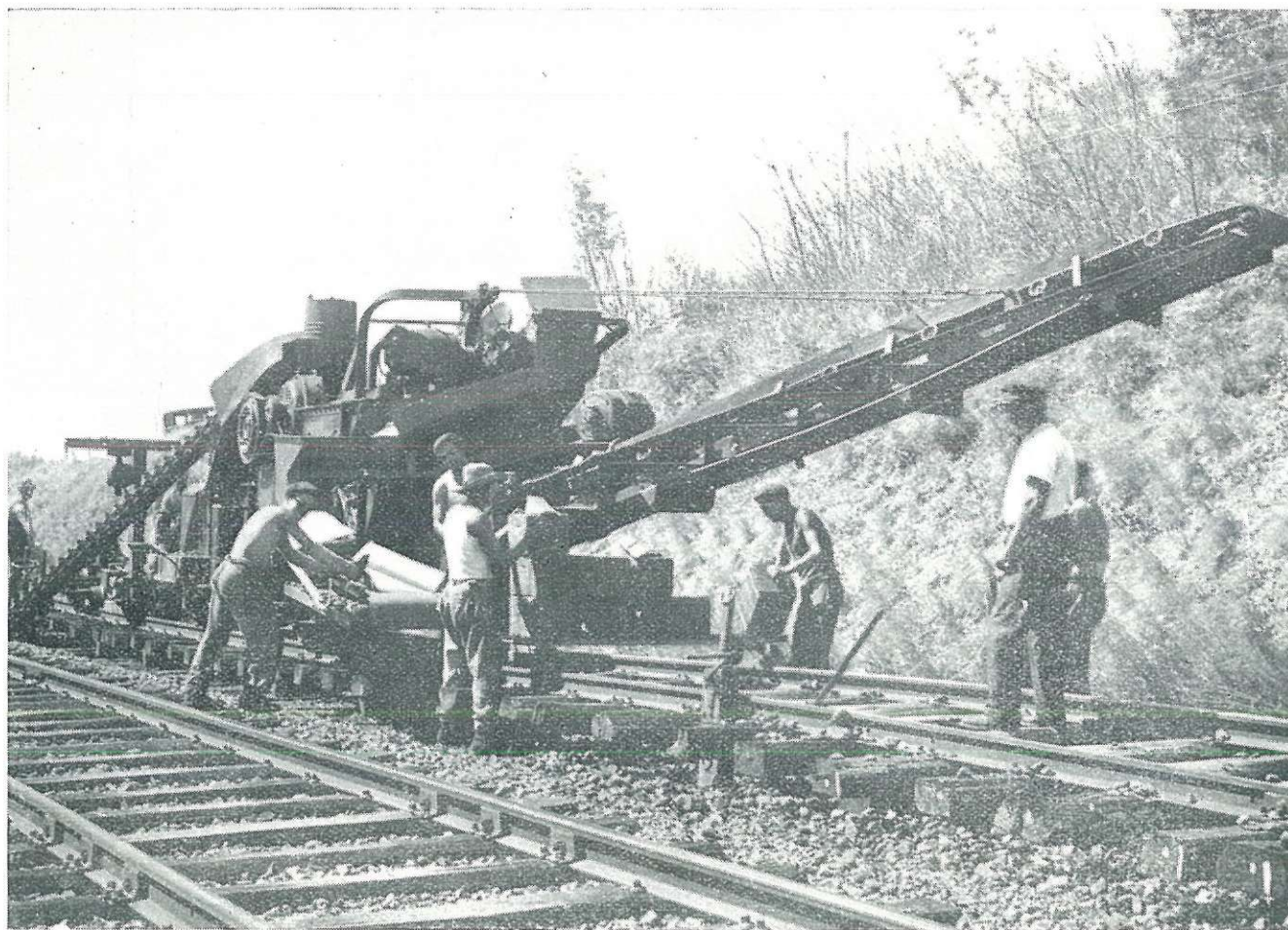
Fig. 3. — Matisa-zeefmachine aan het werk.
