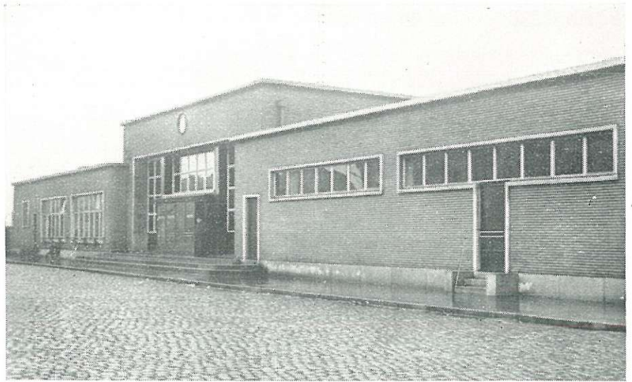
Fig. 7. — Nieuw station te Geraardsbergen.
