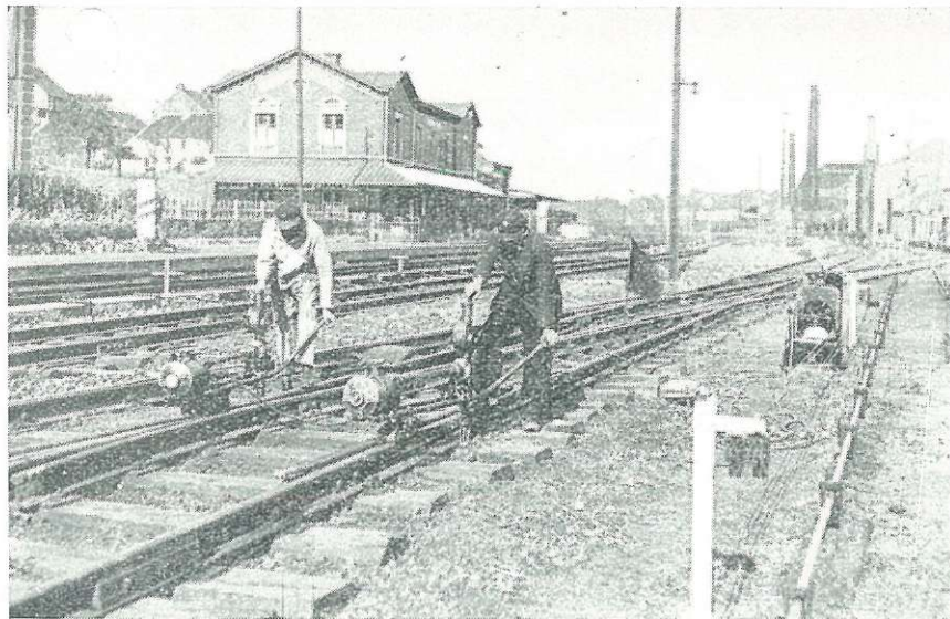
Fig. 2. — Kraagschroefaandraaimachine aan het werk.
