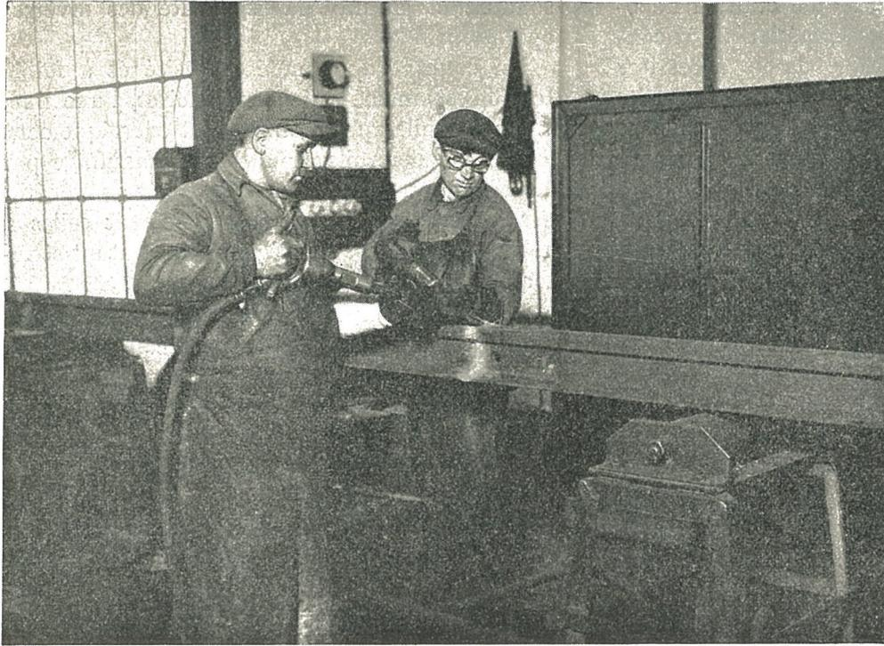
Fig. 2. — Mise sous profil d'un joint immédiatement après soudure.
