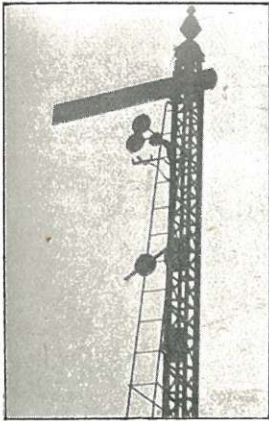
5. — A 8 mètres en avant du signal.
