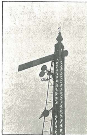
4. — A 7 mètres en avant du signal.
