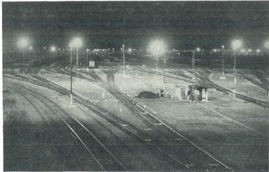
Fig. 30. — Eclairage de la gare de formation d'Anvers-Nord.
