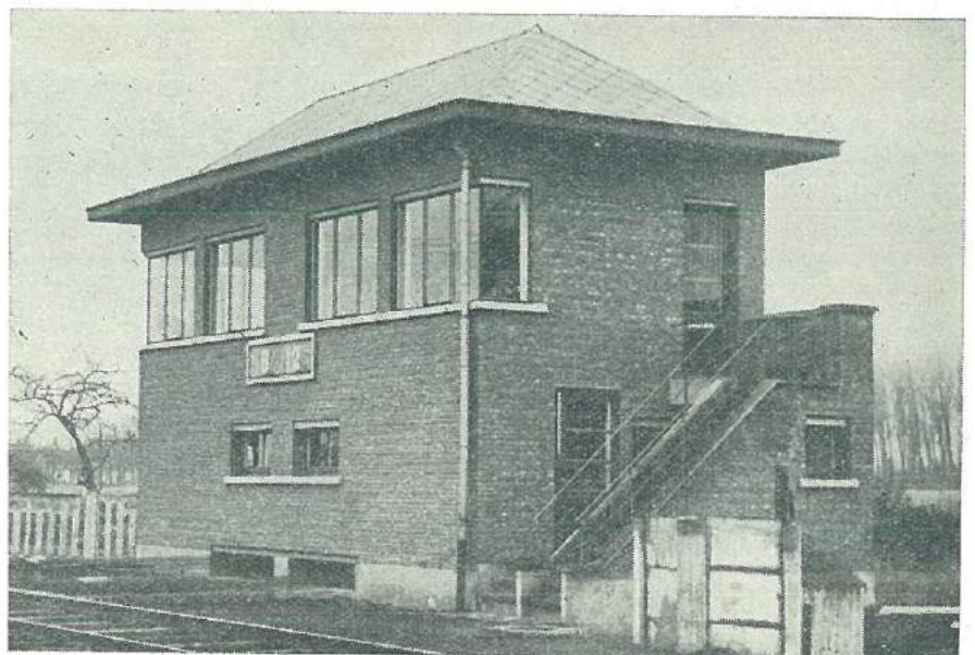
Fig. 4. — Vue extérieure d'une cabine à manœuvre funiculaire.
