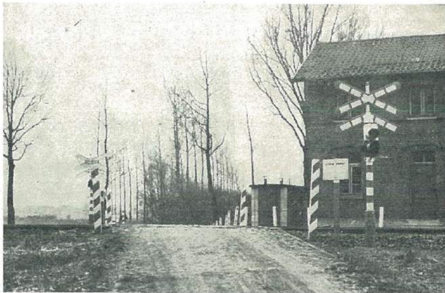
Fig. 16. — Signalisation automatique de passage à niveau non gardé.
