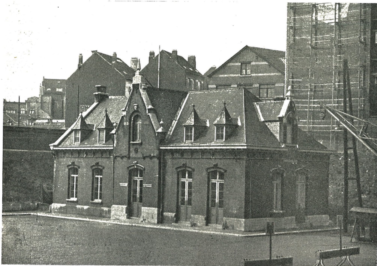
Bâtiment abritant le laboratoire pour emballages, à Bruxelles Tour et Taxis
