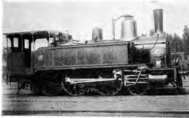
Fig. 18 — Locomotive-tender 2-4-2 T. n° 300 du Gr. C. B. construite en 1878 par la Société de Couillet et exposée à Paris la même année
