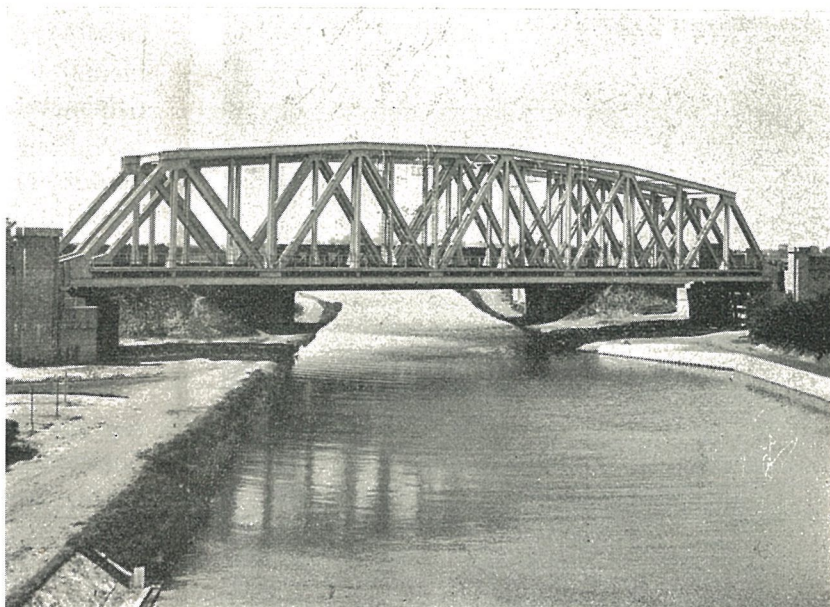
Tabliers d'Oolen. — Vue générale
