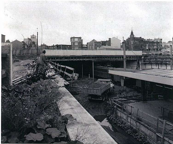
Travaux d'électrification dans le tunnel sous le Cadran en direction de Liège-Guillemins
