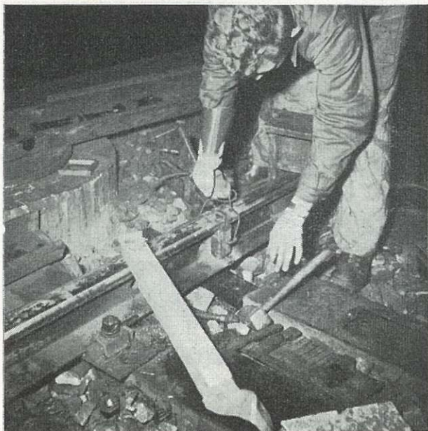
Fig 17. — Remplissage entre les âmes.
