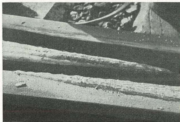
Fig. 42. — Table de roulement en cours de travail de recharge.
