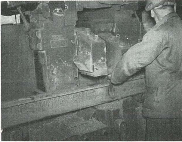
Fig. 27. — Serrage des pièces à souder dans les mâchoires.
