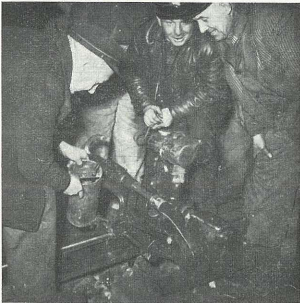
Fig. 13. — Sciage du joint.
