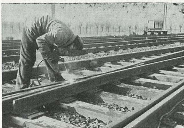
Fig. 39. — Aspect général du chantier.
